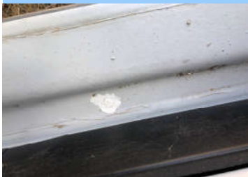
Dùng silicon bít kín các lỗ của inverter của unit1 & unit 2 và phía DC
