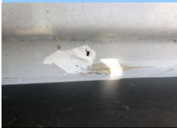
Lưu ý : khi ta bít chứa lại một khe hở nhỏ để thoát nước cho inverter phía unit1&unit2 và phía DC
