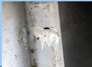
Lưu ý : khi ta bít chứa lại một khe hở nhỏ để thoát nước cho inverter phía unit1&unit2 và phía DC
