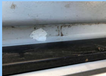
Dùng silicon bít kín các lỗ của inverter của unit1 & unit 2 và phía DC
