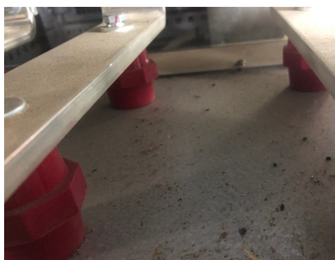
Checking, cleaning all busbars which inside inverter/ kiểm tra và làm sạch tất cả các busbar bên trong inverter
