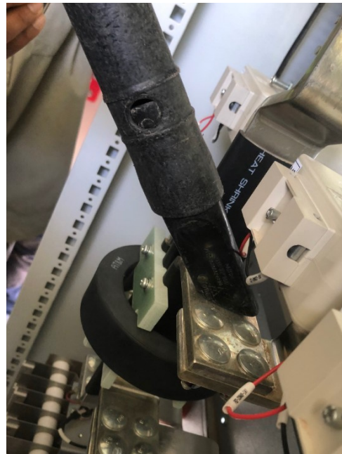
Cleaning all busbars/ làm sạch tất cả busbar
