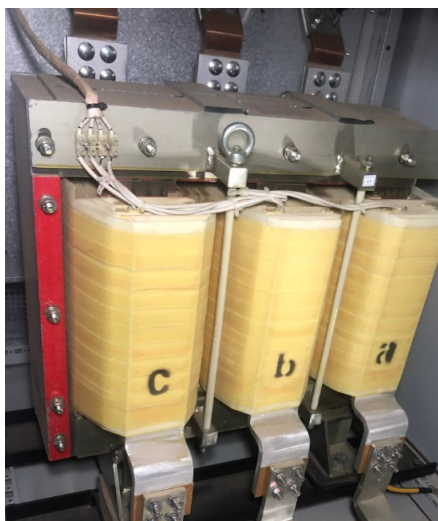
Checking, cleaning reactor and busbar/ Kiểm tra và làm sạch reactor và busbar
