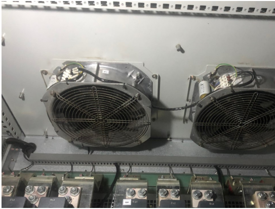
Checking, cleaning fan, main contactor/ Kiểm tra và lạch sạch quạt và contactor chính
