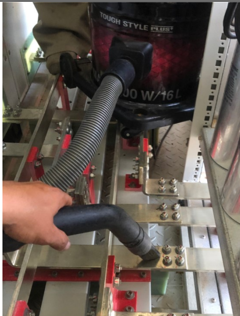
Checking, cleaning fan, main contactor/ Kiểm tra và lạch sạch quạt và contactor chính
